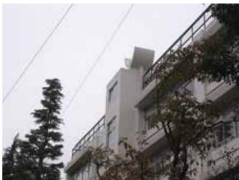
そして、ついに謎に迫る日が来た。屋上に上がると、階段室の屋根の上に、2つの同じ形の物体が並んでいる。これは、給水タンク置き場ではない。ざらっとした表面ではあるが、きれいな局面にコンクリートが打たれている。さらに図面を見せてもらうと、貯水槽詳細図が見つかった。現在は水槽が外され、給水もポンプ式になったので、台だけがオブジェのように取り残されたのだった。オブジェでなかったことに、少しがっかりしたのであったが、設計時期などを確認してみると、昭和36年の図面であるので、モダニズムの流れに乗っている可能性はある。窓上部や扉上部の庇のデザインもまた、同じ鉄筋コンクリートでつくられ、モ
